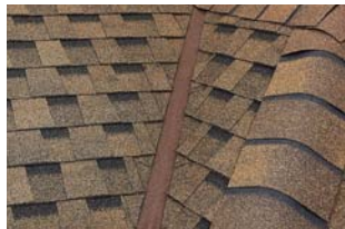
Калифорнийская ендова (один из вариантов открытого способа)
